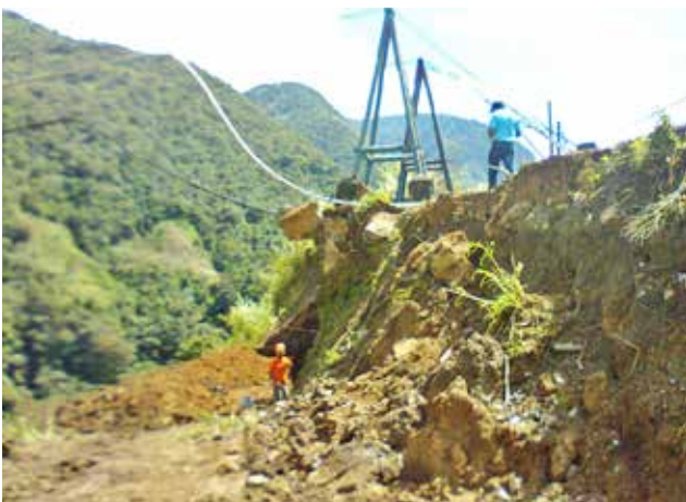
Construcción de un muro para la protección de las torres de agua en el sector El Placer
