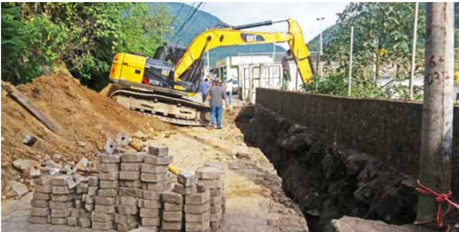
Construcción del anclaje del muro en la vía antigua junto al centro de salud
