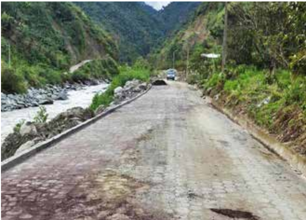
Colocación de adoquinado y construcción de un badén, sector La Playa
