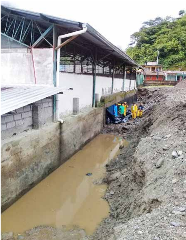
Impermeabilización de la pared del coliseo
